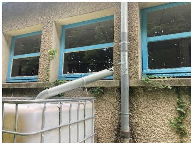
*Figure 62 : récupération des eaux de pluie par la gouttière de l'école*
