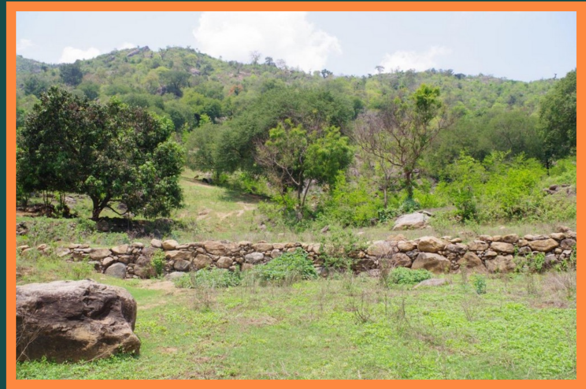
Mur en pierre pour lutter contre érosion du sol (Jawadhu Hills) ©
